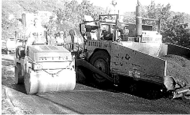
Lavori in corso nelle strade di Cicagna per la sistemazione dell'asfalto
