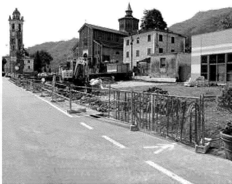
I lavori in corso a Cicagna nella zona della piscina
