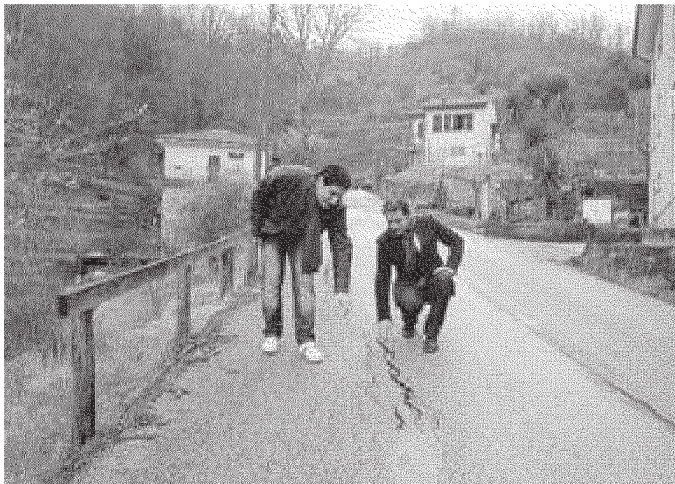
Il cedimento in località Frugaie rischia di bloccare l'intera Serra di Cicagna
